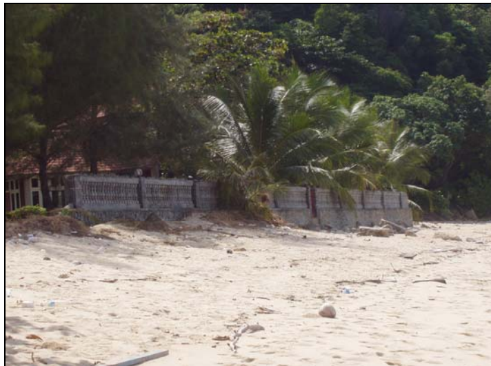
Gambar 18: Tembok konkrit yang menghalang laluan di pantai Pasir Panjang
