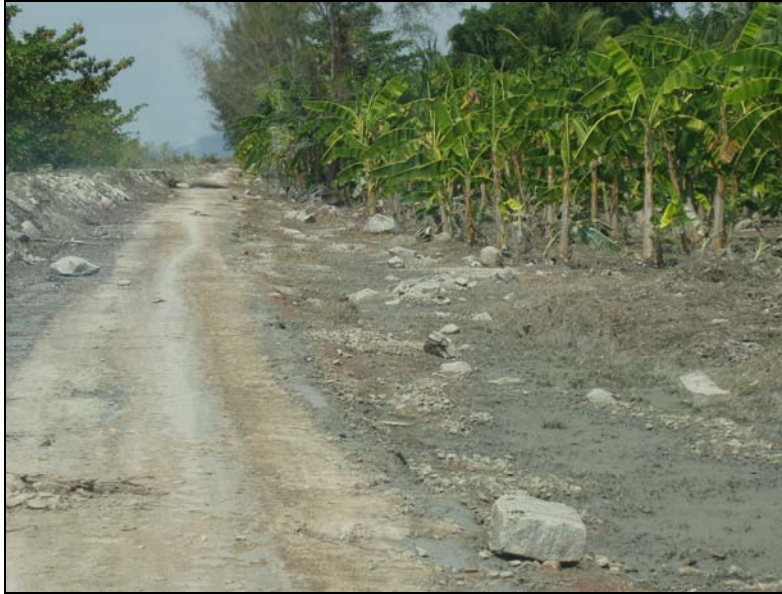
Gambar 13: Limpahan ombak menaburkan batu lebih binaan lapis-lindung. Tanda paras limpahan air setinggi hampir 1 meter masih kelihatan pada batang pokok pisang.
