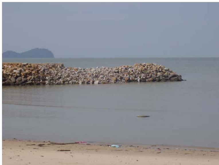
Gambar 24: Kerosakan kecil kepada pemecah ombak yang dilimpahi tsunami
